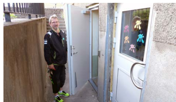
Vår fastighetsvärd Magnus vid två av de nya, mer inbrottsäkra källardörrarna.
